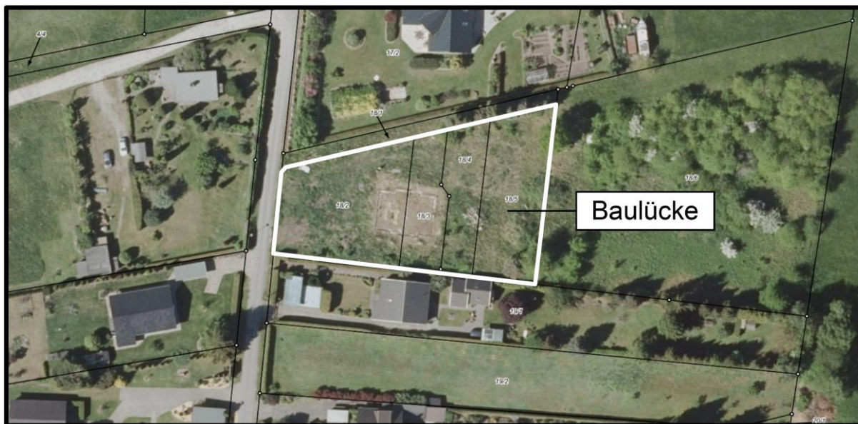
Abbildung 8: Baulücke am Wiesenweg mit sichtbarem Fundament eines nicht fertiggestellten Wohnhauses (Quelle: IPO, Hintergrund: Landesamt für innere Verwaltung unter - https://www.geoportal-mv.de/gaia/gaia.php )
